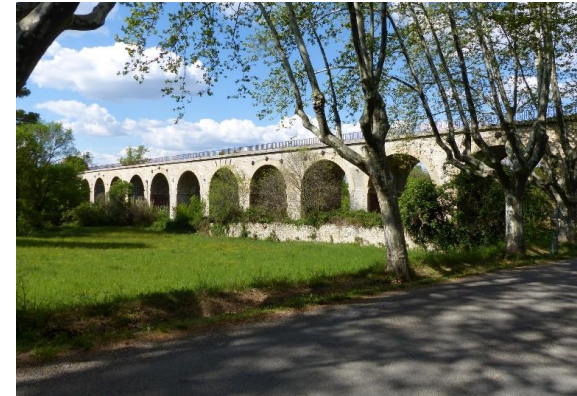
Le pont qui signe une mise en tension du paysage de très grande qualité
